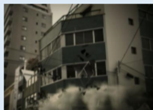
強い揺れによる 建物崩壊
